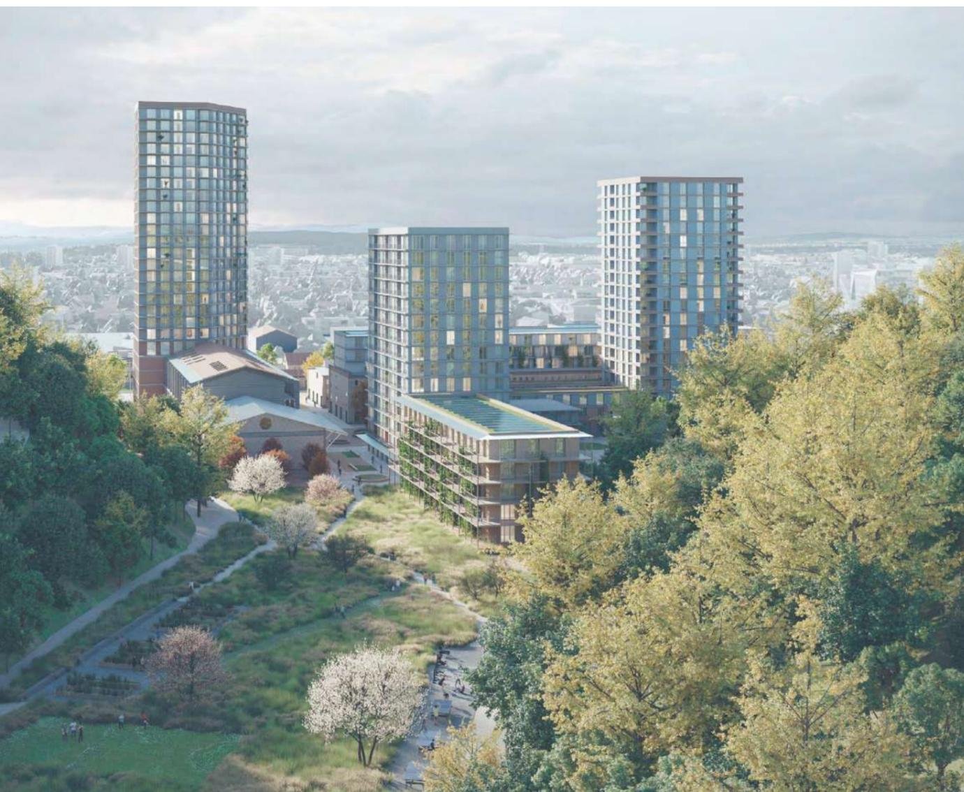
Das Projekt wird durch drei Höhenabstufungen charakterisiert: Drei Hochhäuser mit bis zu 24 Geschossen und 80 m Höhe bilden die Hochpunkte, die Gebäude mittlerer Höhe (20 m) bilden eine Zwischenstufe und die ursprüngliche Höhe der Ziegelei-Bauten (10 m) stellt die niedrigste Gebäudeschicht dar.
